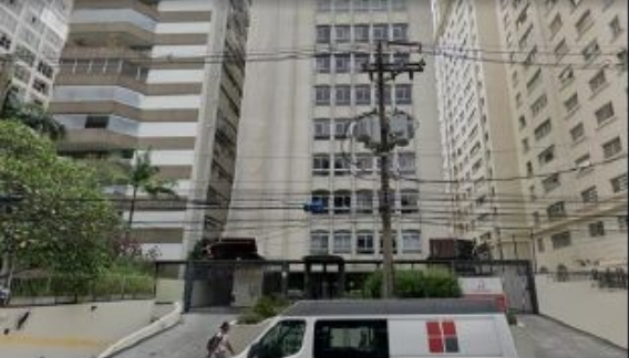
Antes (e sem a construção de novas varandas )
